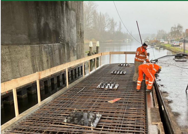
De wapening in het steunpunt in de Ringvaart
